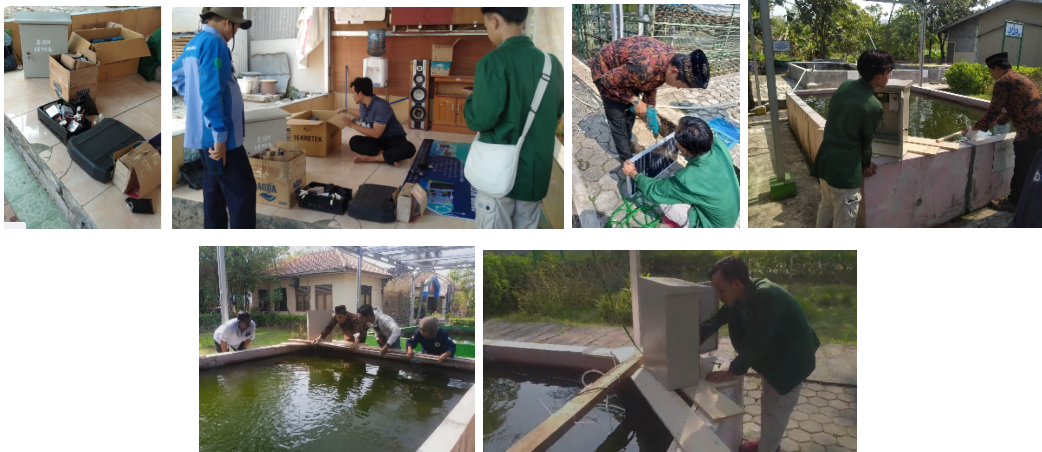
Gambar 7. Proses pemasangan E-Ox Level
