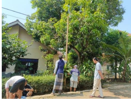
Gambar 4. Pemasangan LPJU Di Jalur Desa Dengan Partisipasi Langsung Warga Sekitar.
