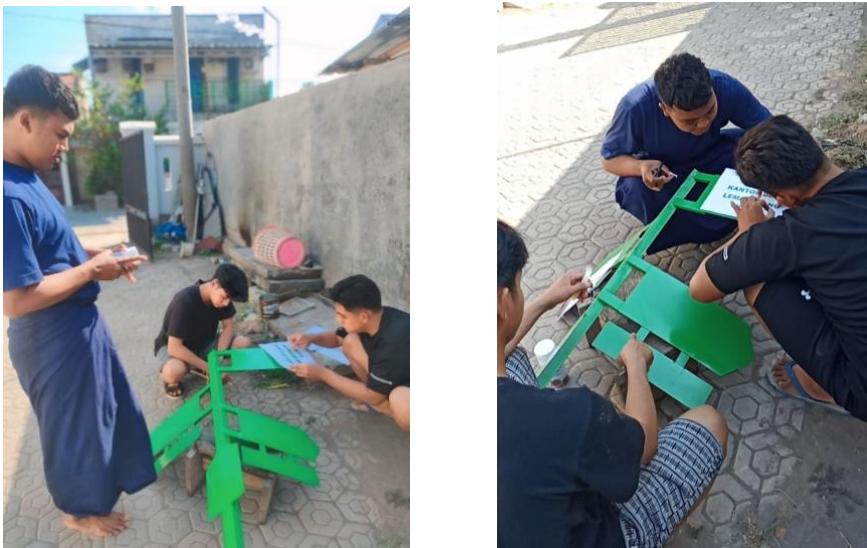
Gambar. 3.2 Proses Pemasangan Nama di Plang Jalan
